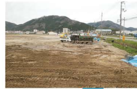
令和元年5月 造成工事開始
