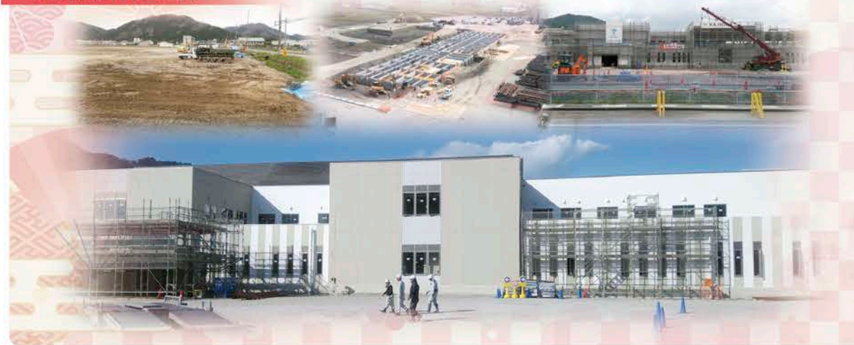
新病院建設工事の様子
