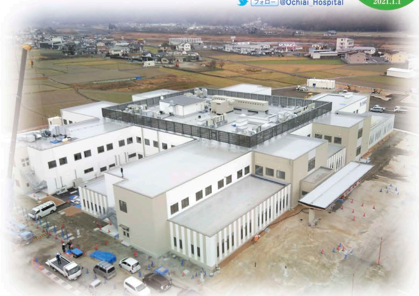
写真/新病院建設工事の様子
